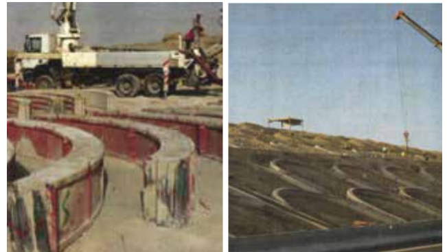
Figure 7 : Illustration des travaux de réalisation des arcades sur les autoroutes au Maroc
