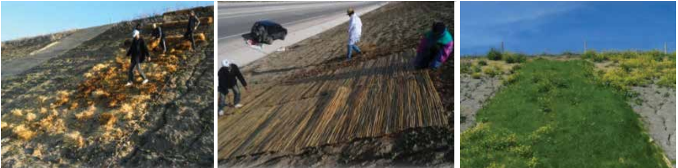
Figure 6 : Photos des travaux et résultats de fixation des sols par les techniques de génie biologique sur les autoroutes au Maroc
