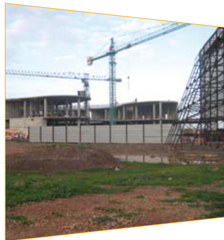
Une vue du chantier du Morocco Mall.
