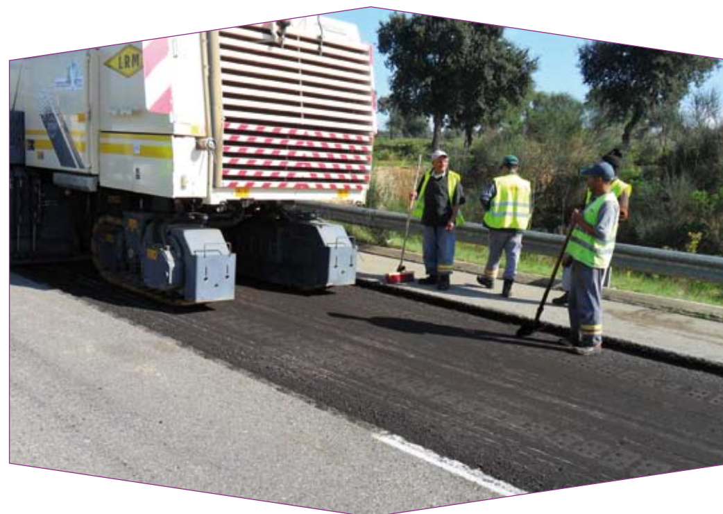
Travaux d'enrobage d'une autoroute.
