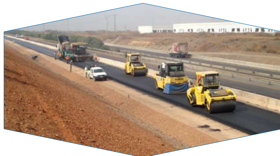
Travaux d'enrobage sur l'axe autoroutier Casablanca-Rabat.
