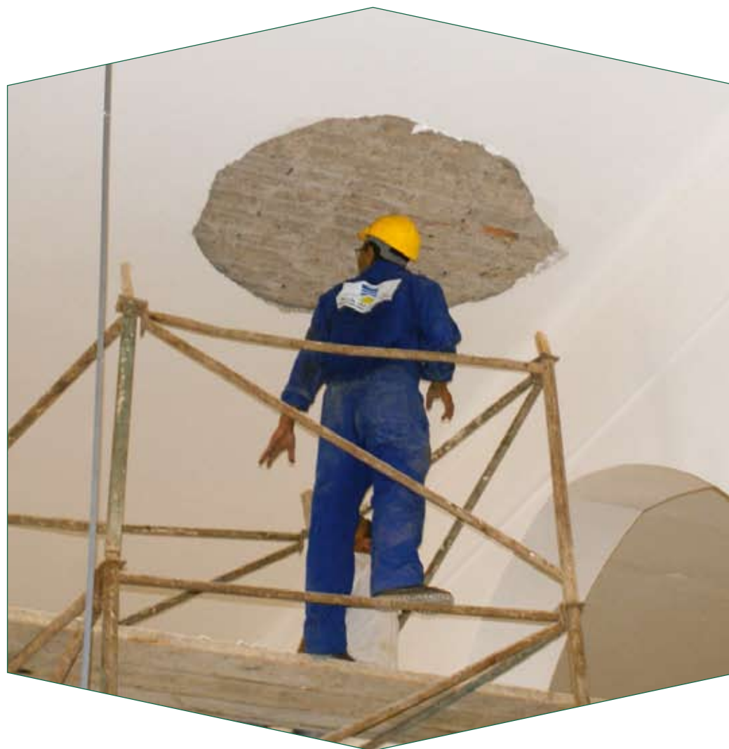
Travaux de réfection d'un plafond d'une salle de prière d'une mosquée.
