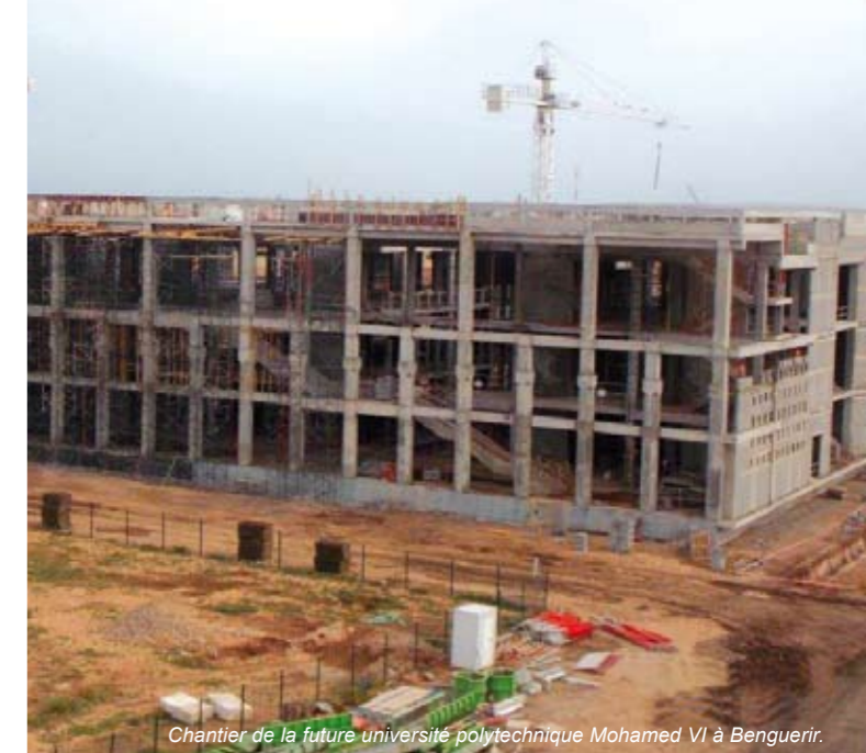
Chantier du futur centre de formation de l'OCP à Benguerir.
